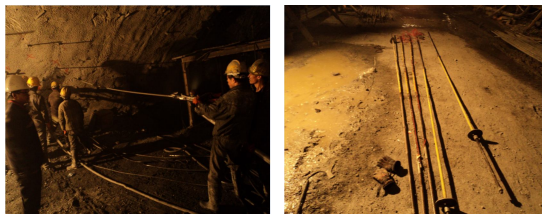
(a) 现场测试钻孔
